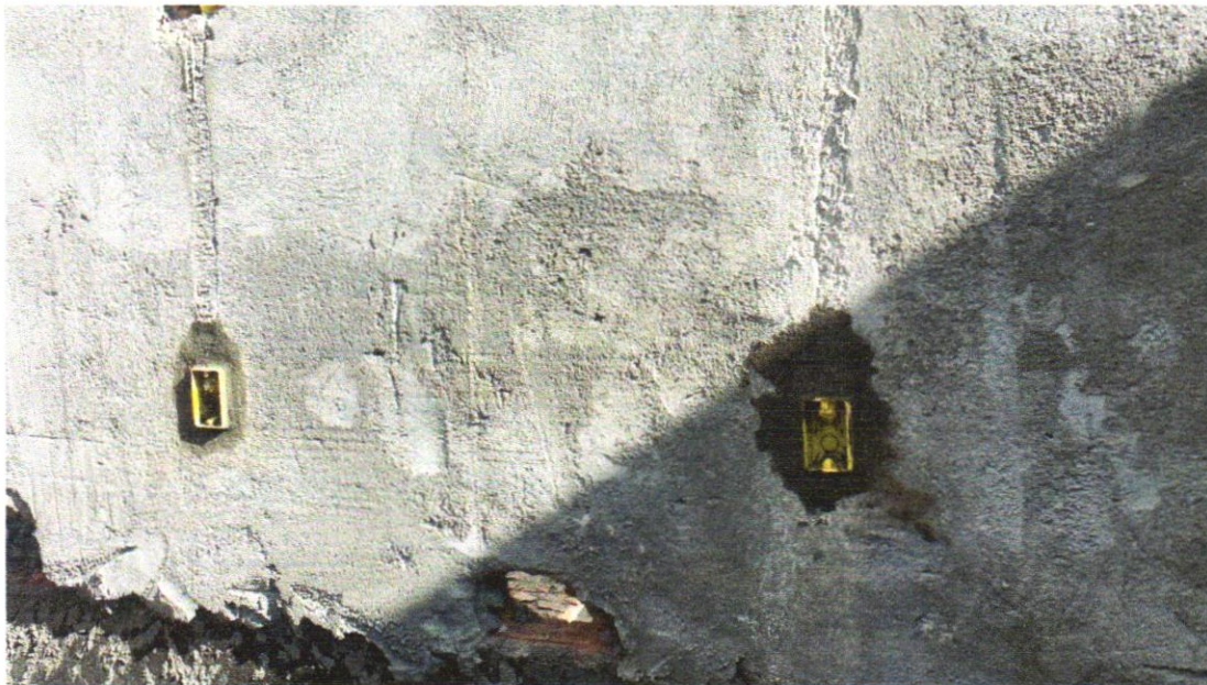
FOTO 78 – Caixa de passagem PVC 4x2"
