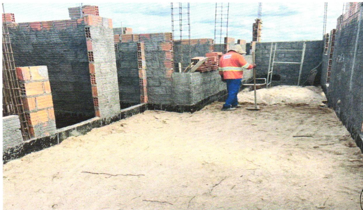
FOTO 06 – ATERRO MANUAL DE VALAS COM SOLO ARGILO-ARENOSO E COMPACTAÇÃO MECANIZADA. AF_05/2016
