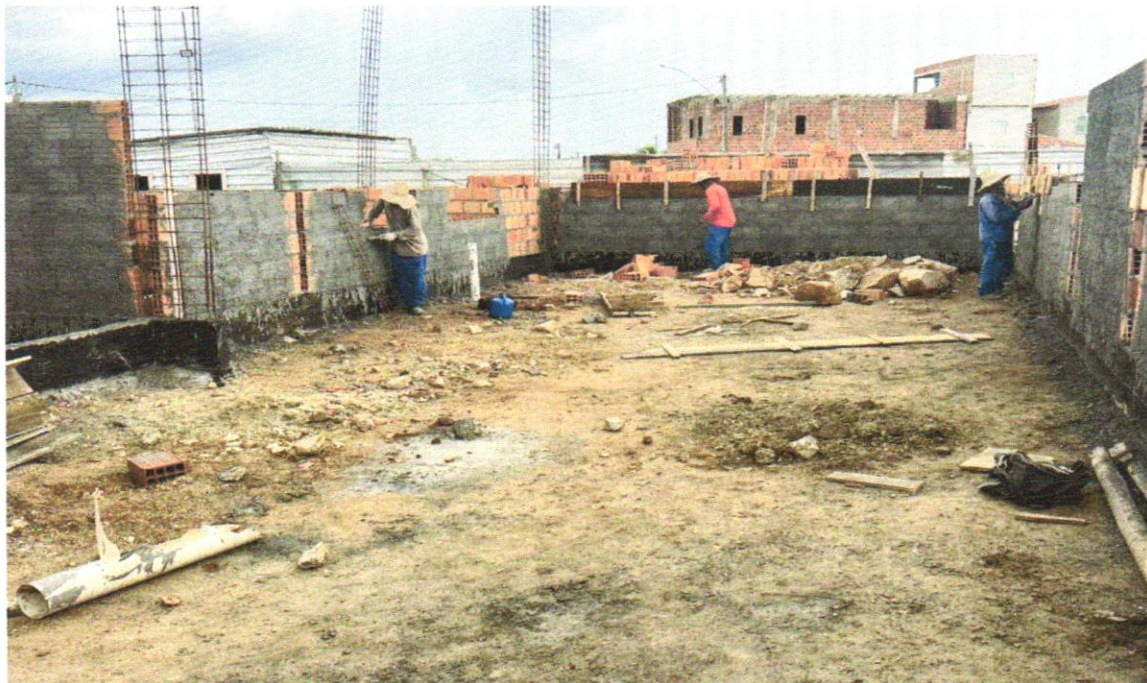
FOTO 56 – Chapisco de aderência em paredes internas, externas, vigas, platibanda e calhas.
