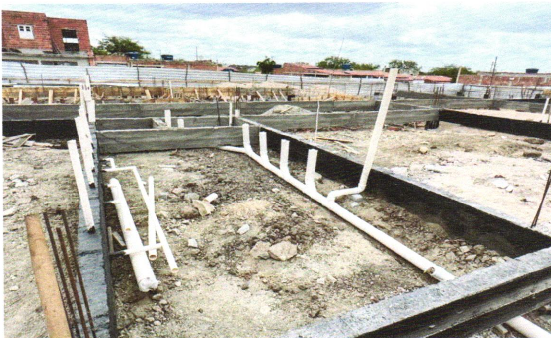
FOTO 64 – TUBO PVC, SERIE NORMAL, ESGOTO PREDIAL, DN 100 MM, FORNECIDO E INSTALADO EM RAMAL DE DESCARGA OU RAMAL DE ESGOTO SANITÁRIO. AF_08/2022
