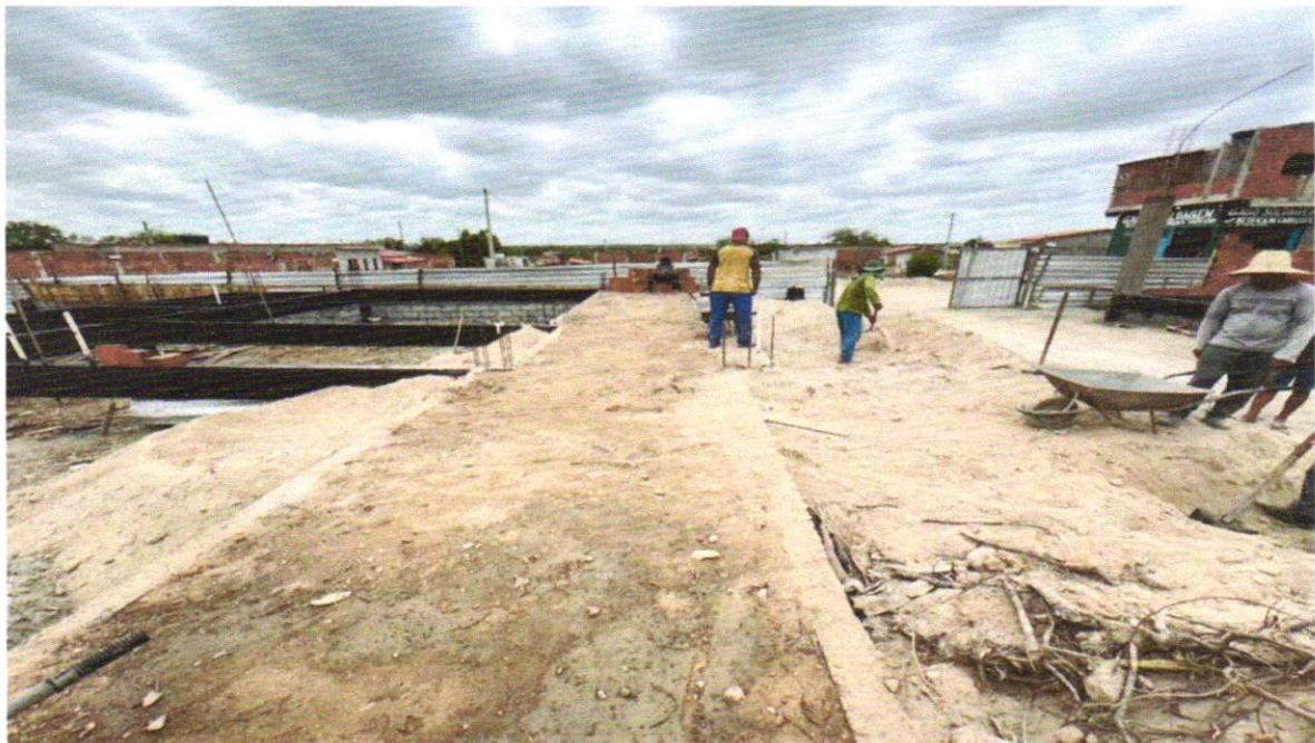
FOTO 02 - ATERRO MANUAL DE VALAS COM SOLO ARGILLO-ARENOSO E COMPACTAÇÃO MECANIZADA. AF_05/2016
