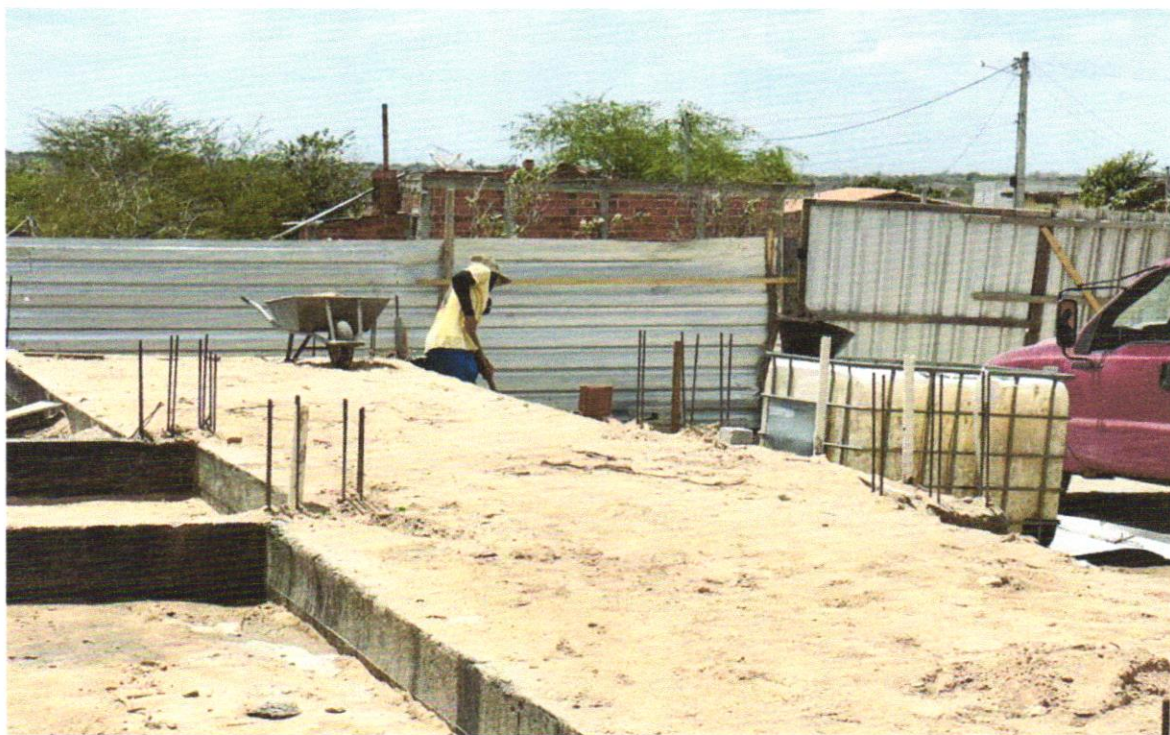
FOTO 08 – REATERRO MANUAL DE VALAS COM COMPACTAÇÃO MECANIZADA. AF_04/2016
