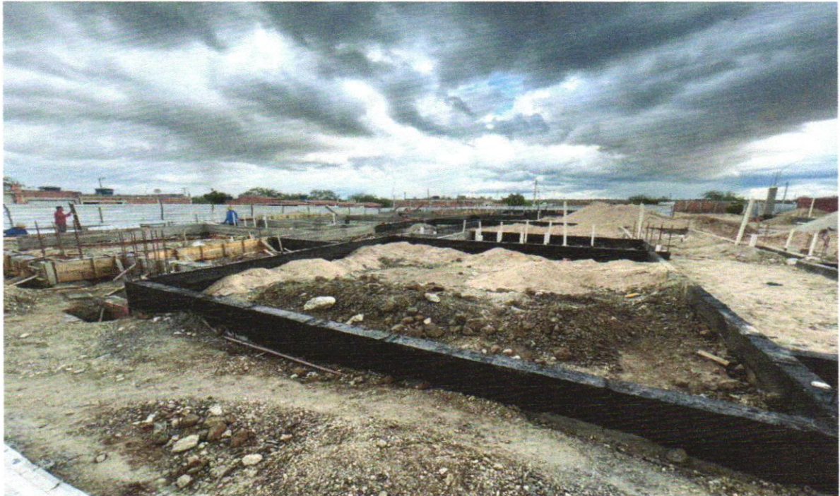
FOTO 10 – LASTRO DE CONCRETO MAGRO, APLICADO EM PISOS, LAJES SOBRE SOLO OU RADIERS, ESPESSURA DE 5 CM. AF_07/2016
