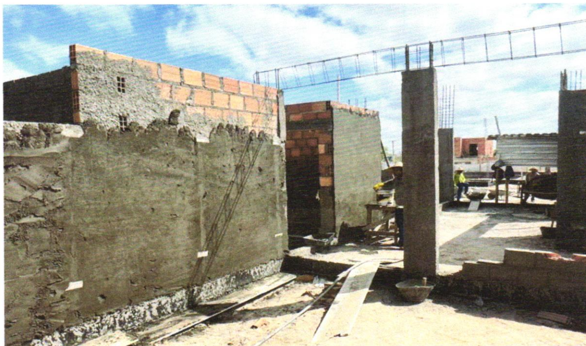
FOTO 58 – Emboço para paredes internas traço 1:2:9 - preparo manual - espessura 2,0 cm
