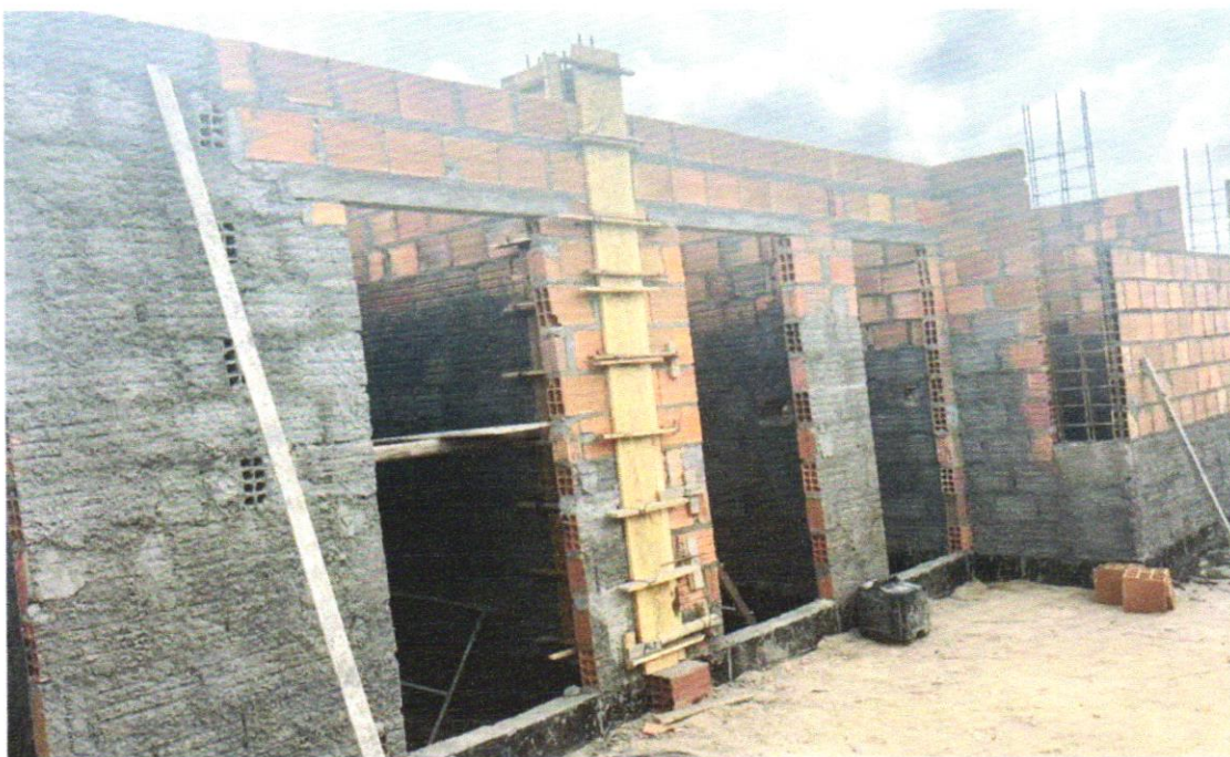
FOTO 44 – Verga e contraverga pré-moldada fck= 20MPa, seção 10x10cm
