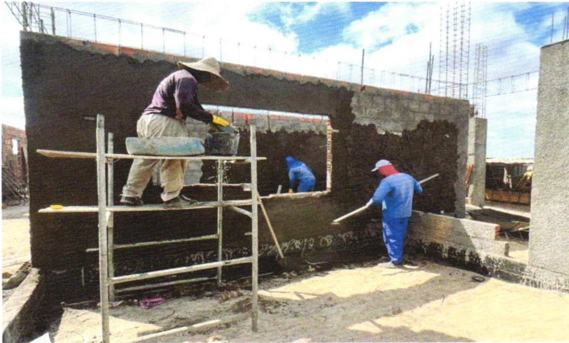
FOTO 58 – Emboço para paredes internas traço 1:2:9 - preparo manual - espessura 2,0 cm
