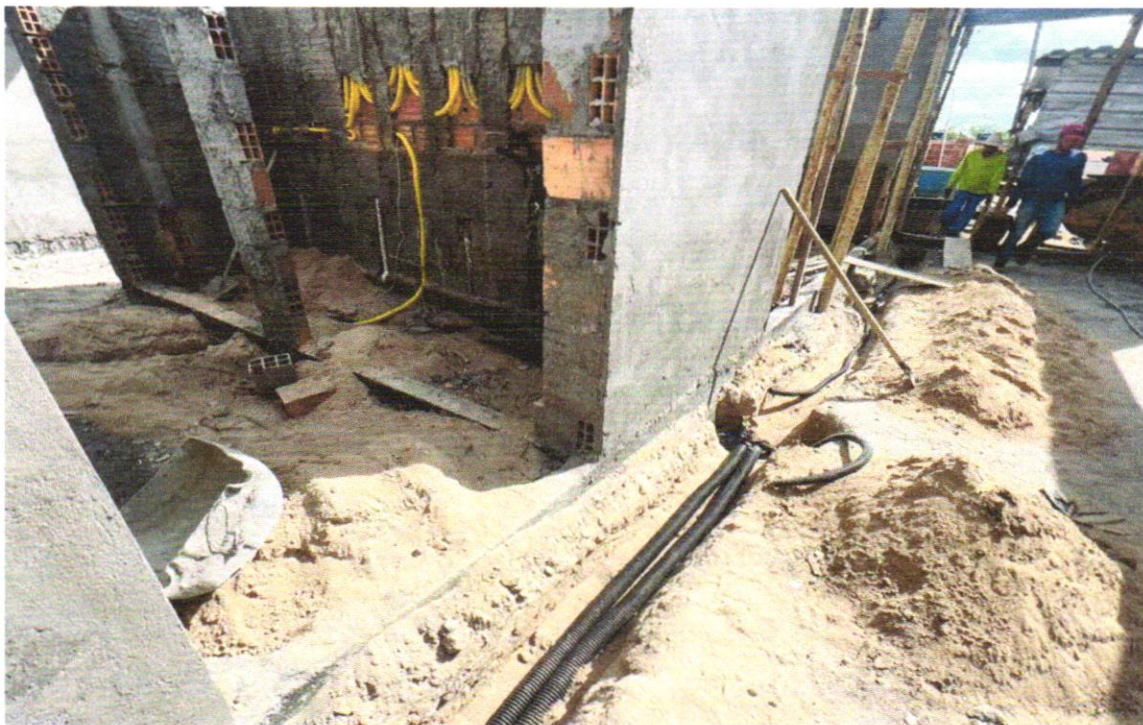
FOTO 84 – Eletroduto PVC flexível corrugado reforçado, Ø32mm (DN 1"), inclusive conexões
