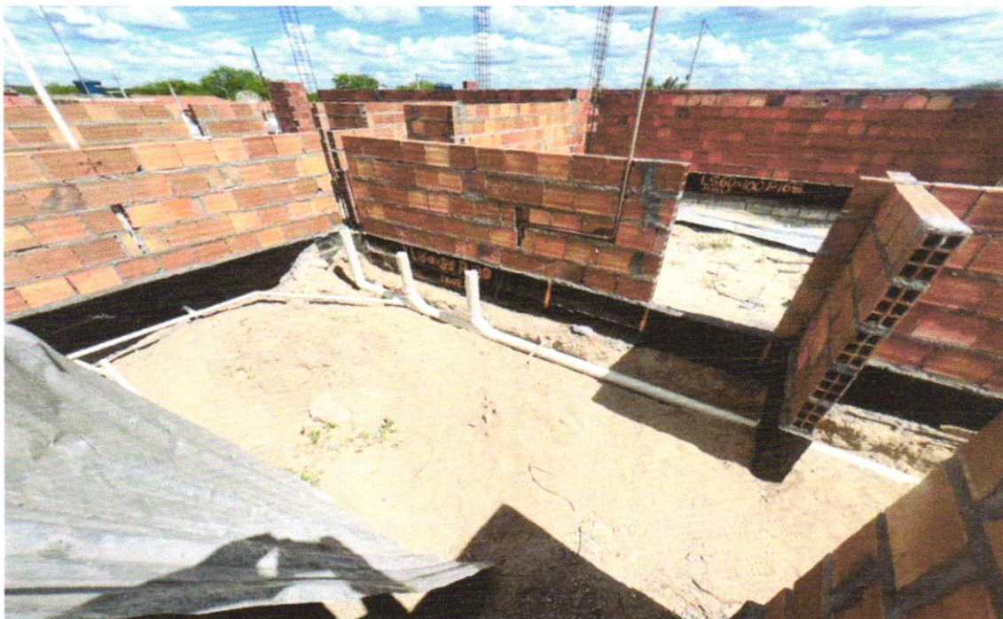
FOTO 70 – TUBO PVC, SERIE NORMAL, ESGOTO PREDIAL, DN 100 MM, FORNECIDO E INSTALADO EM RAMAL DE DESCARGA OU RAMAL DE ESGOTO SANITÁRIO. AF_08/2022
