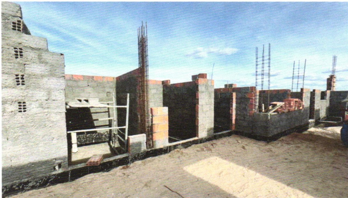
FOTO 06 – ATERRO MANUAL DE VALAS COM SOLO ARGILO-ARENOSO E COMPACTAÇÃO MECANIZADA. AF_05/2016
