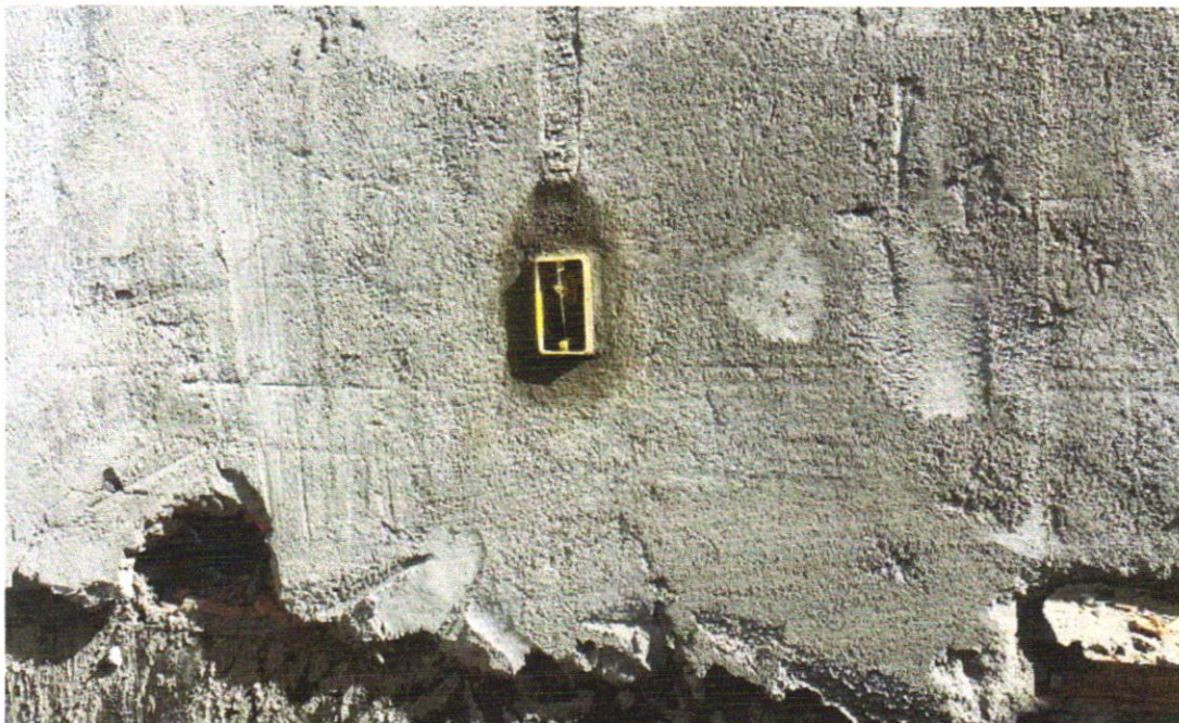
FOTO 76 – Caixa de passagem PVC 4x2"
